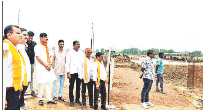
कुटरा में निर्माणाधीन मेडिकल कॉलेज भवन का निरीक्षण करते भाजपा पदाधिकारी।
